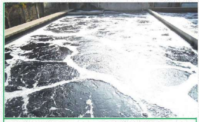
8) Aerobic Digester -01
