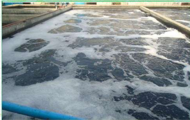
9) Aerobic Digester -02
