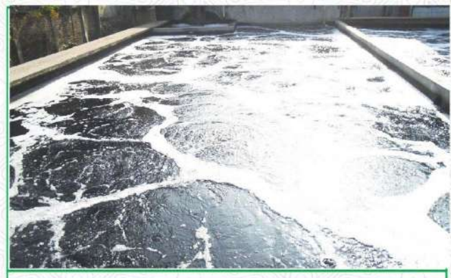
8) Aerobic Digester -01
