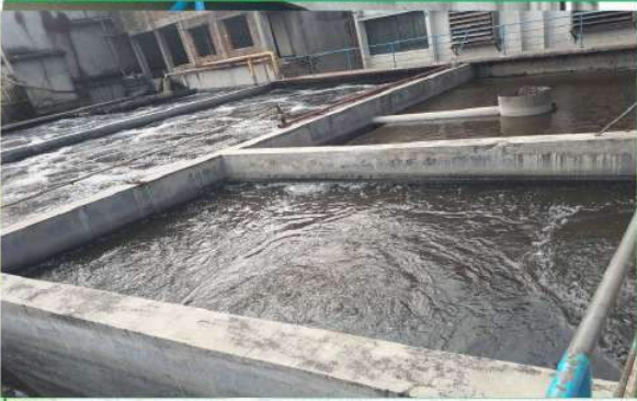
13) Sludge Return Tank
